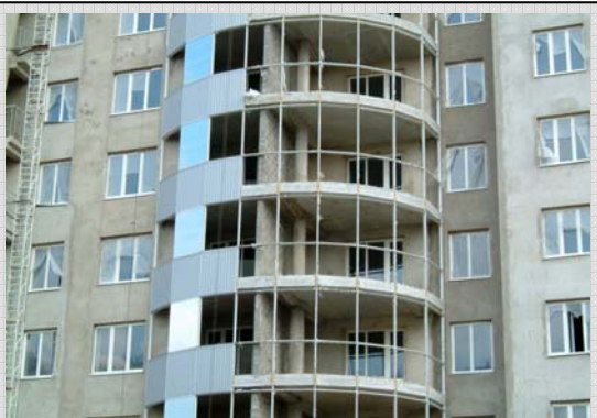
Балконы каркасного здания, обустроенные монолитным пенобетоном
