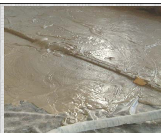
Расплыв пенобетонной смеси за счет высокой подвижности
