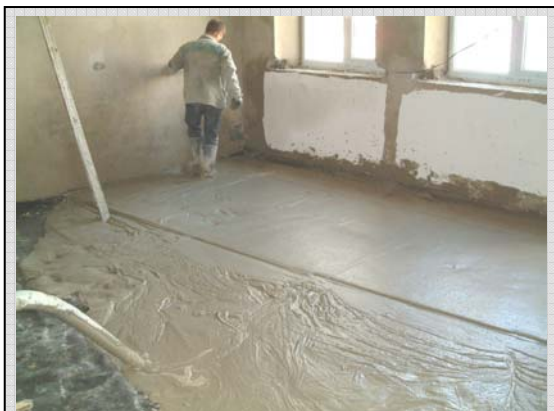
Пенобетонную смесь укладывают полосами, ограниченными маячными рейками
