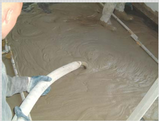
Устройство полов на основе монолитного пенобетона
