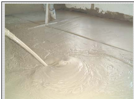
Укладку и выравнивание пенобетонной смеси ведут непрерывно
