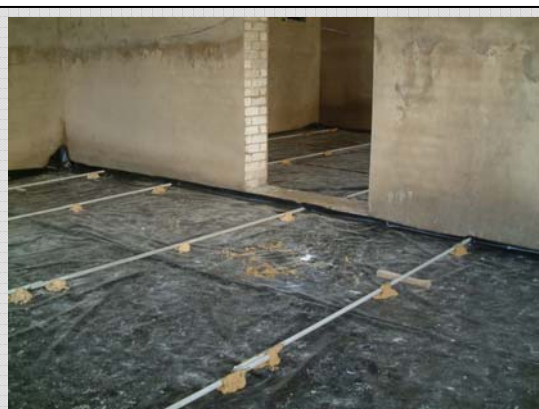
Направляющие для выравнивания пенобетонных слоев
