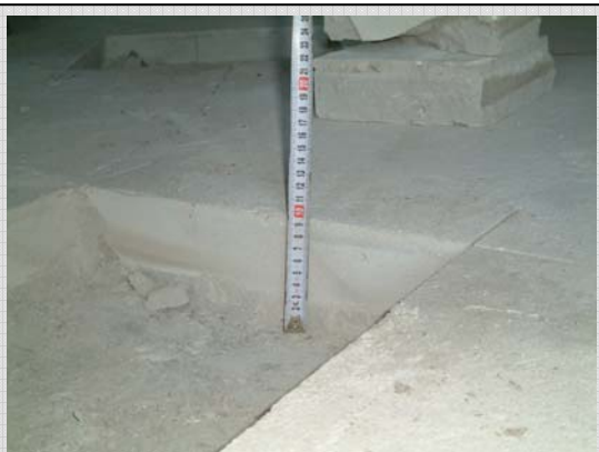
Контроль толщины теплозвуко- изоляционного пенобетонного слоя и растворной стяжки
