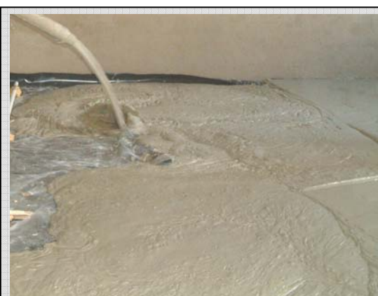
Укладка монолитного пенобетона
